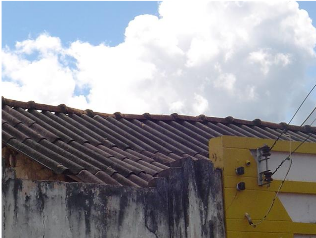
Vista do telhado em telha de fibrocimento.
