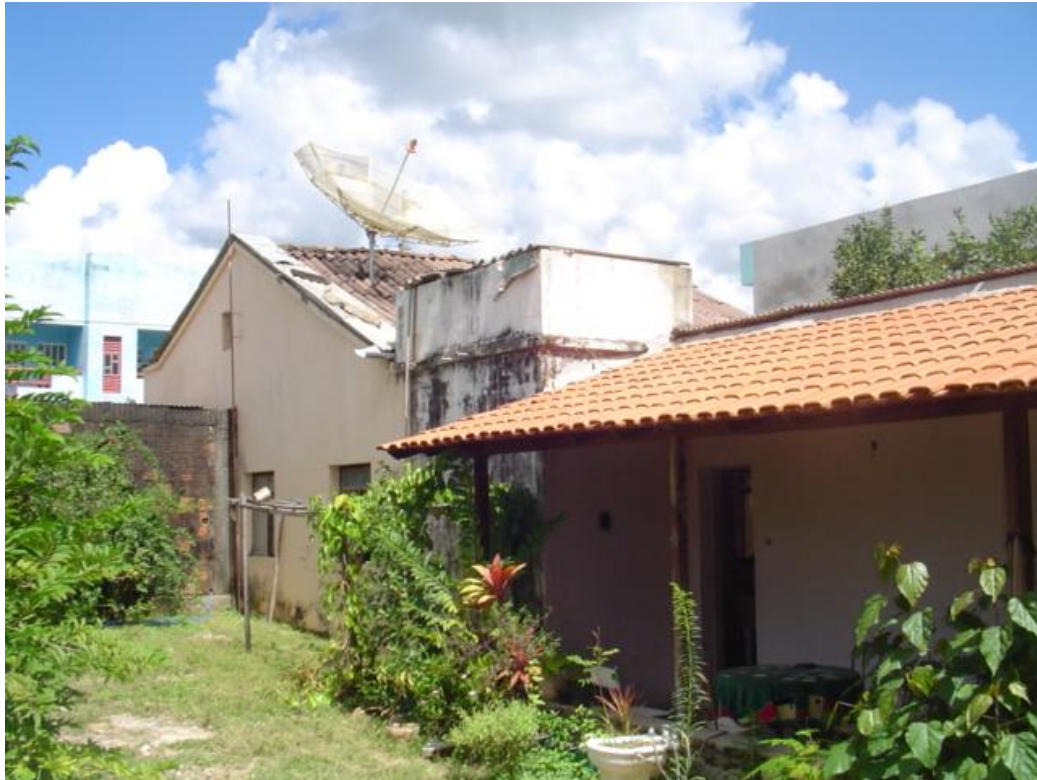
Vista da fachada lateral esquerda.
