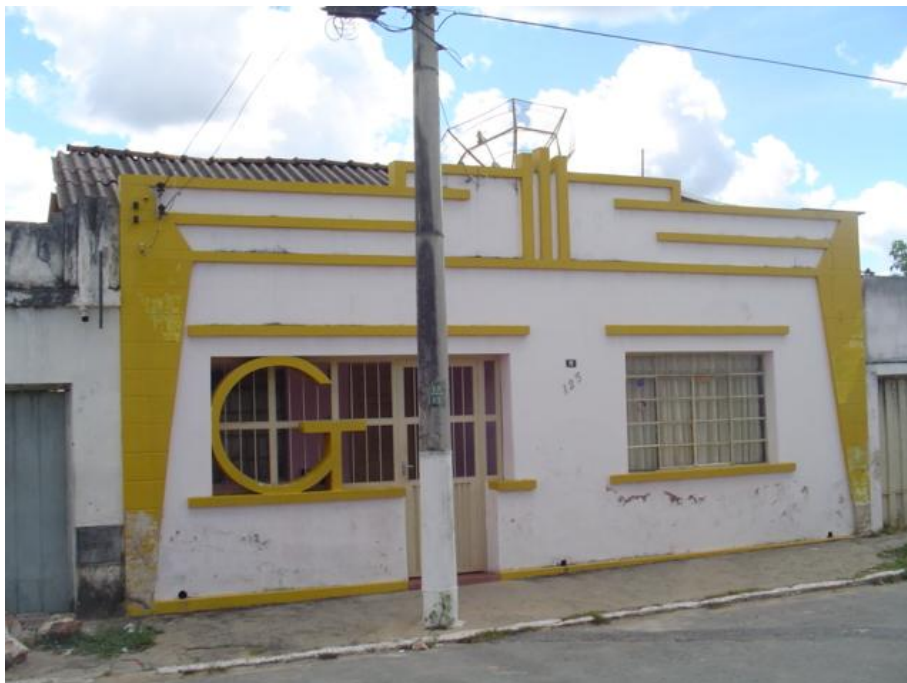
Vista da fachada principal.
