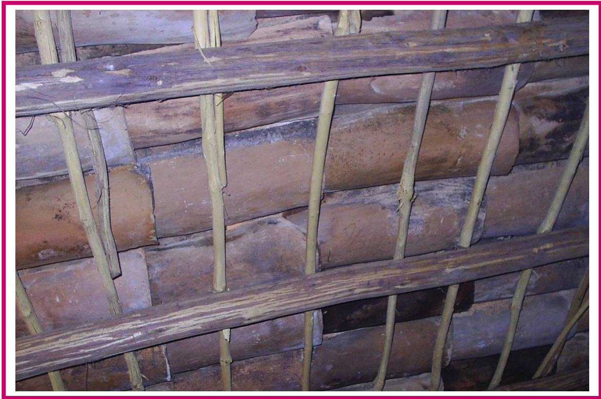
Detalhe do telhado.
