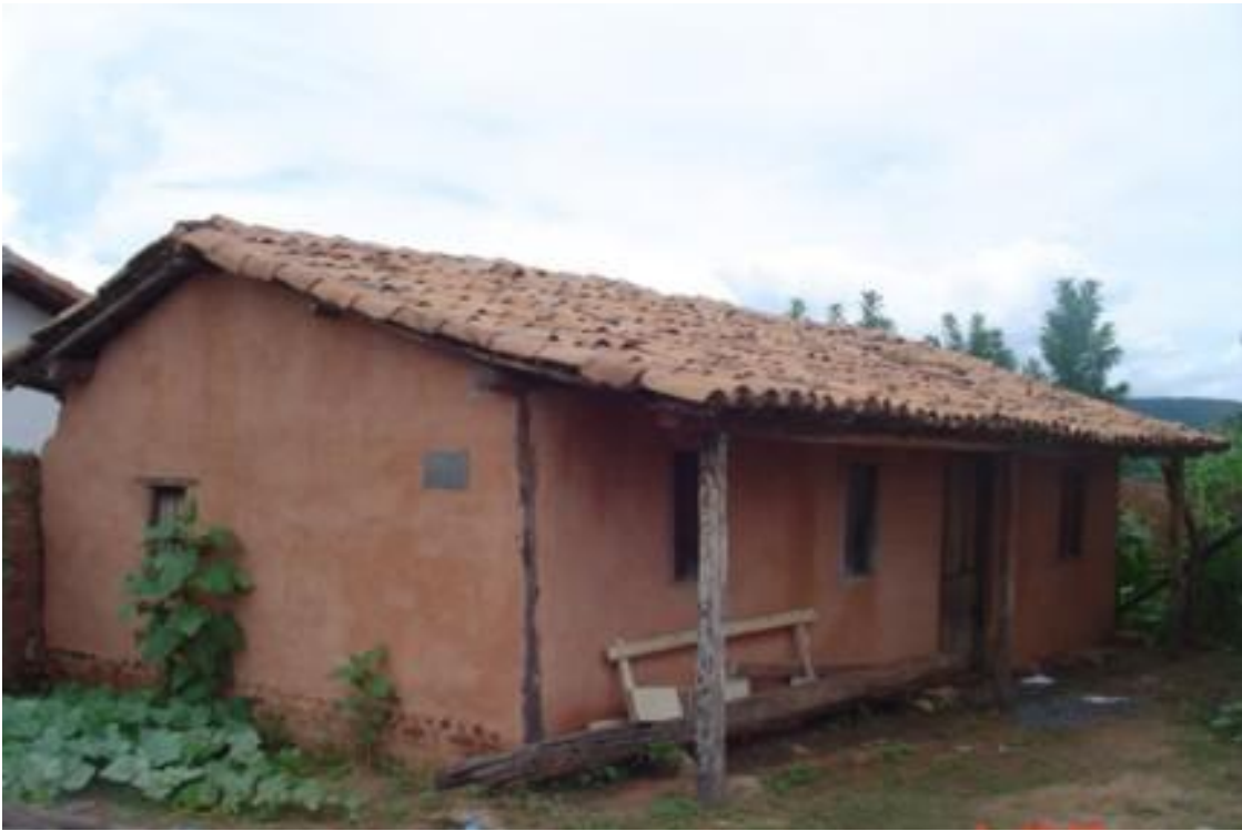
Vista da fachada principal e da fachada lateral esquerda da casa de Juca Surdo.
