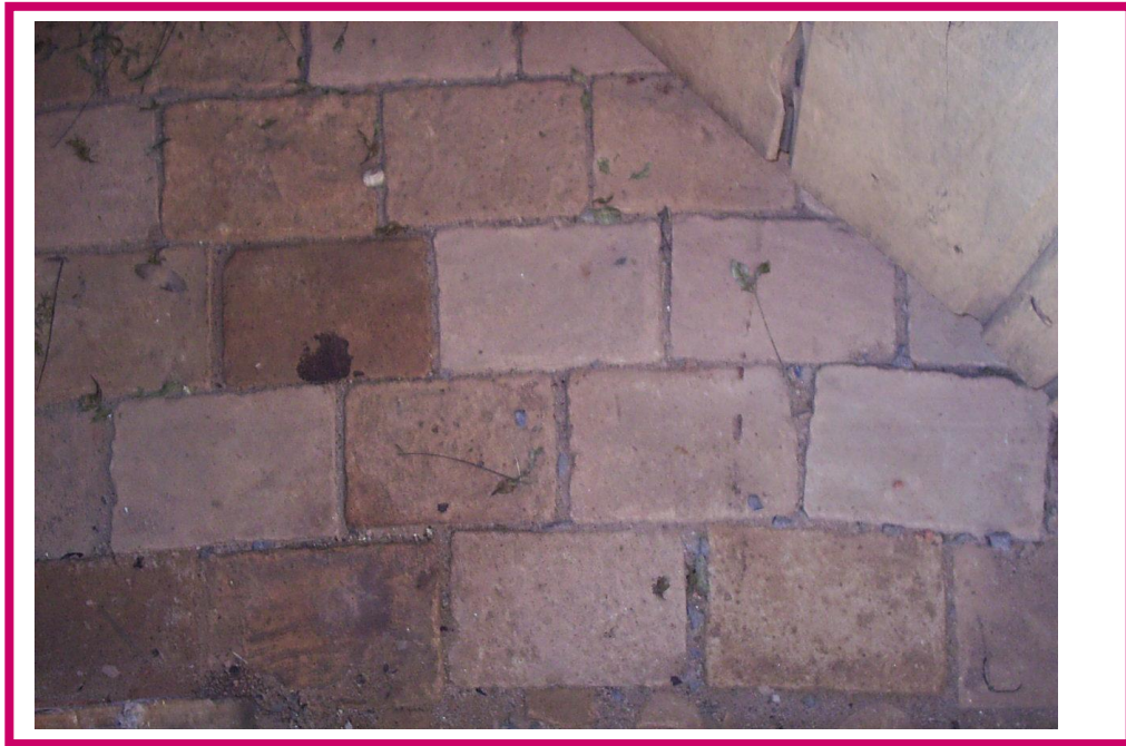
Detalhe na parte inferior da foto: piso
