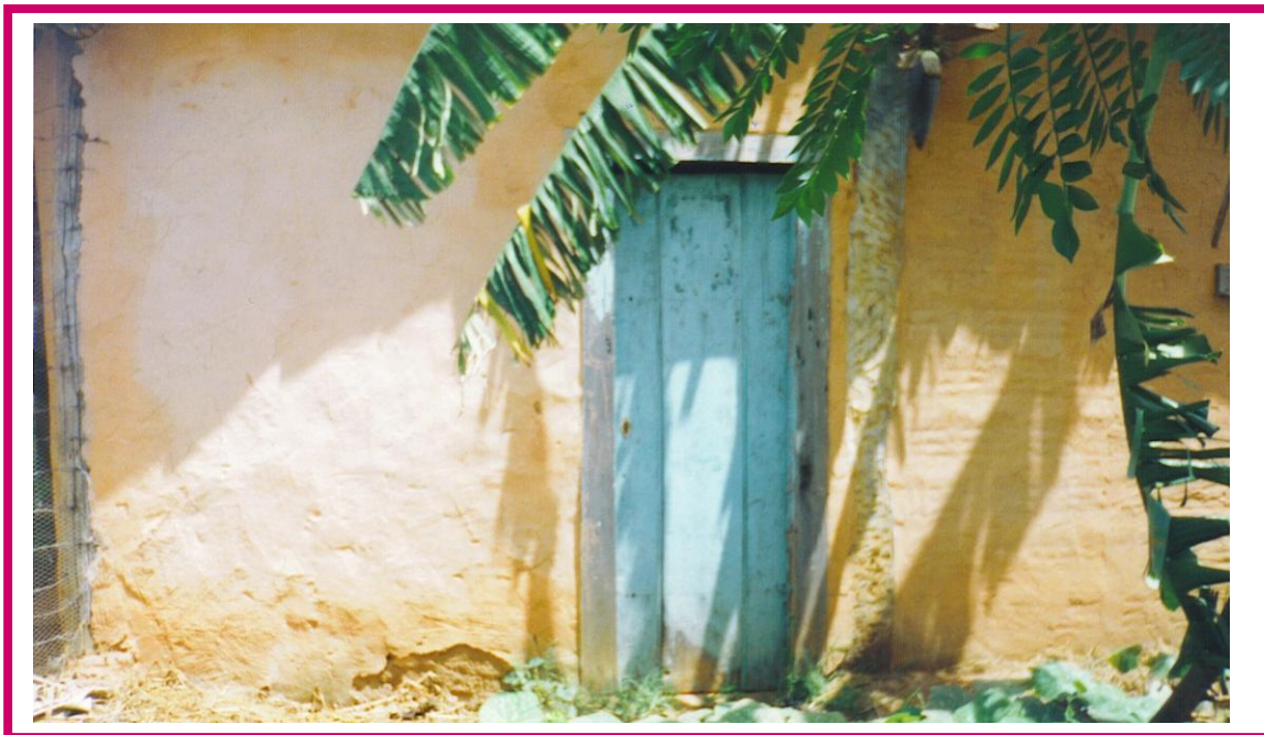
Vista da fachada lateral esquerda.
