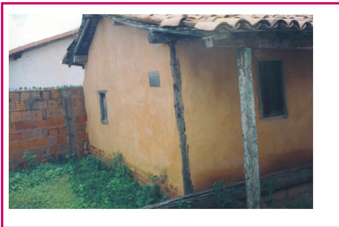
Vista da fachada lateral direita.
