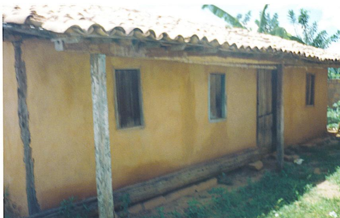
Vista da fachada principal.
