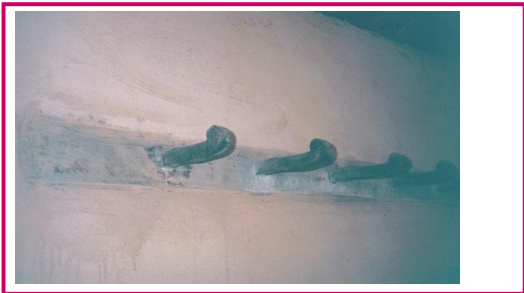
Detalhe da parede interna.
