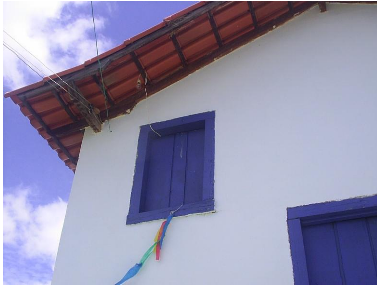
Vista parcial da fachada principal enfocando telhado e janela
