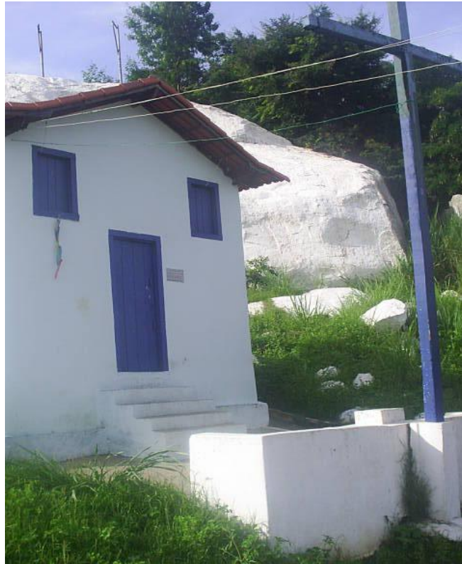
Vista da fachada principal
