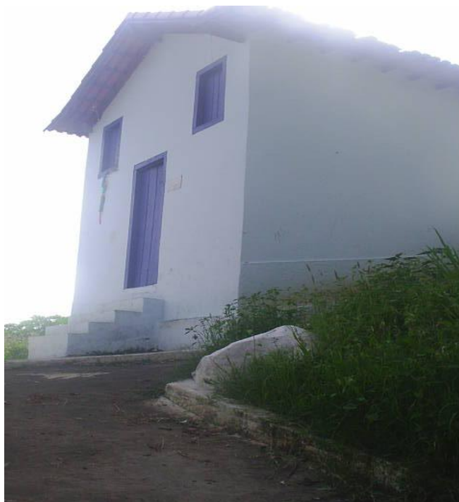
Vista da fachada principal e lateral esquerda da Capela
