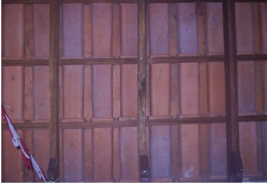
Vista do interior da Capela: telhado.
