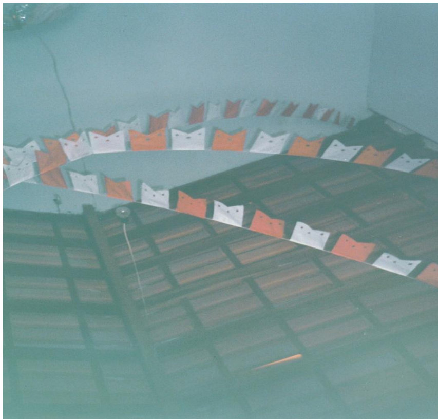
Vista do interior: telhado.
